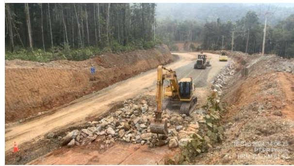
Gambar. 4 Proses penghamparan dan penataan batu boulder nikel berukuran 20–50 cm sebagai matras batuan ( rock mattress ) pada jalur hauling KM 61–63.
