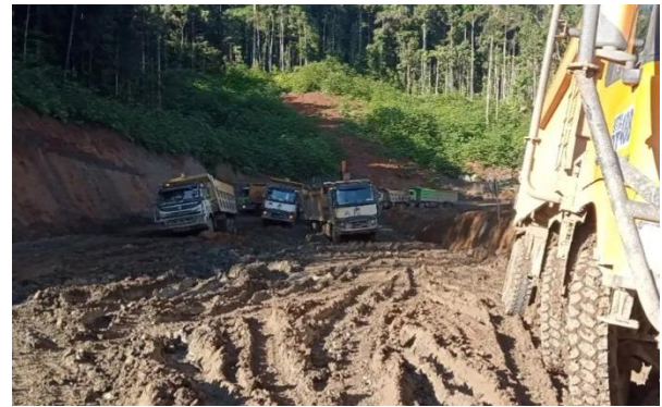
Gambar. 1 Kondisi visual jalur hauling KM 61-63 PT Weda Bay Nikel akibat saturasi material cuttingan pada musim hujan.
