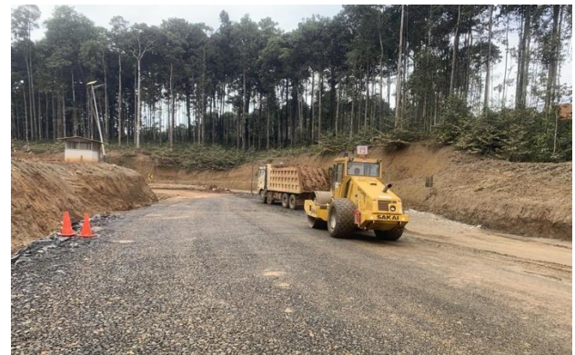
Gambar. 5 Kondisi permukaan lapisan sub-base setelah dilapisi dan dipadatkan menggunakan batu pecah ukuran 5/7 cm ( chocking material ) pada jalur hauling KM 61–63.
