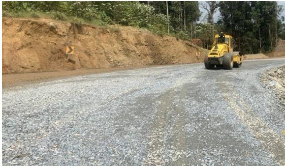
Gambar. 6 Kondisi hasil akhir ( final surface ) permukaan jalan hauling KM 61–63 yang telah siap dan aman dilalui armada Dump Truck (DT) secara penuh.
